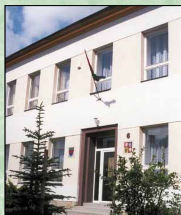
Opravená budova obecního úřadu a lékaře
